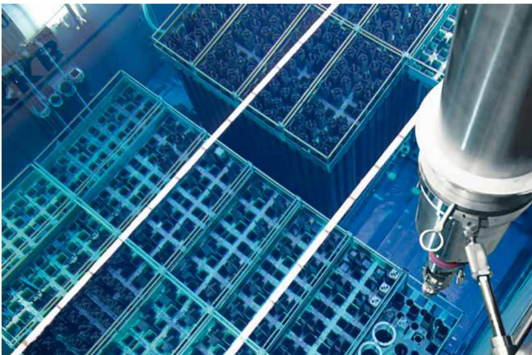
Blick in das Brennelementlagerbecken des Kernkraftwerks Krümmel. Die Brennelemente lagern in einem mit Wasser gefüllten Becken. Dort werden sie gekühlt und ständig überwacht. Foto: Vattenfall (KKW Krümmel)
